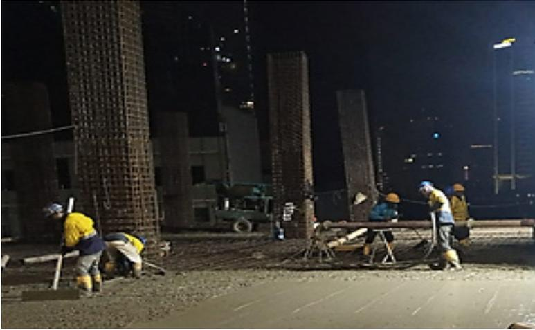
**Gambar 5.2** Proses Pengecoran Pelat Lantai
