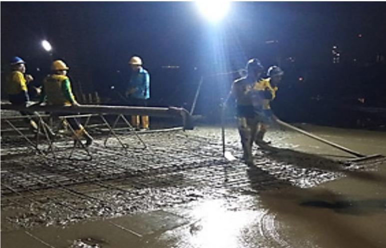
**Gambar 5.3** Proses Meratakan Adukan Beton Pada Pelat Lantai
