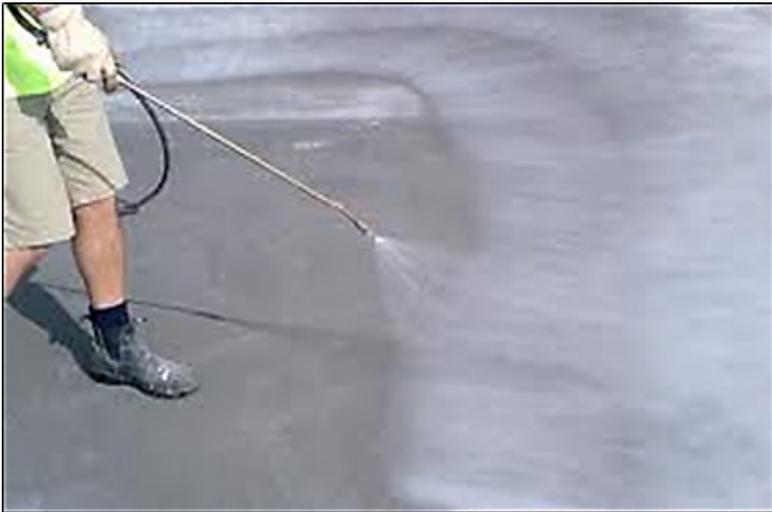
**Gambar 5.4** Proses Curing Pada Pelat Lantai
