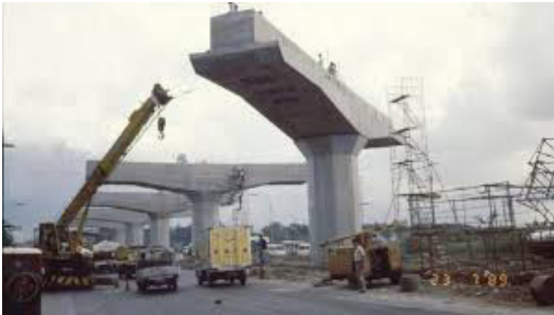
Gambar 6 Pembangunan Infrastruktur Jalan Tol
