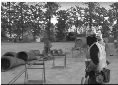
**Gambar 5.5.** Alat bantu kerja pembesian berupa tetrapot sebagai meja kerja
