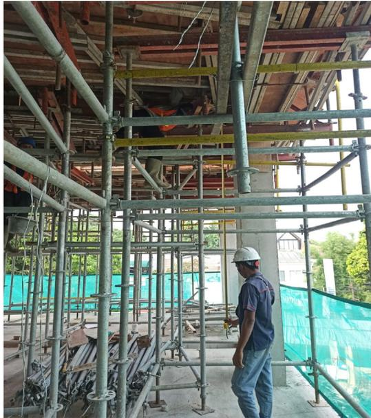
**Gambar 3.8** Mengukur Ketinggian Balok sesuai dengan Elevasi
