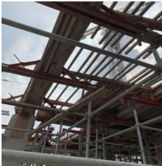
**Gambar 3.10** Meletakkan Besi Hollow 50 x 50 mm
