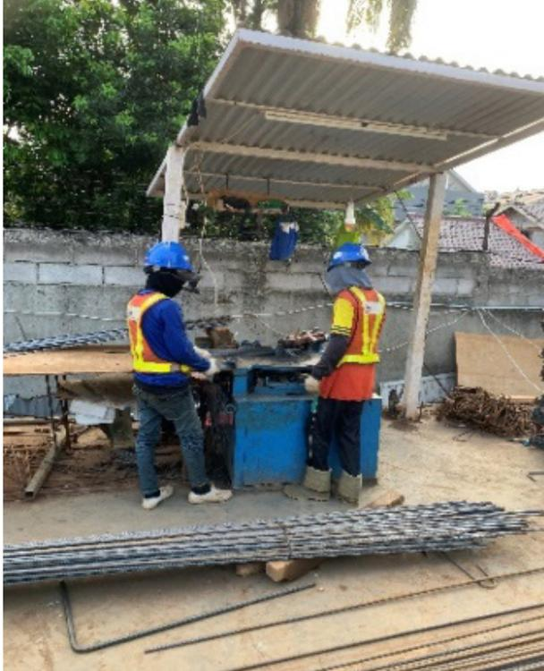
**Gambar 4.6** Proses Pemotongan Besi
