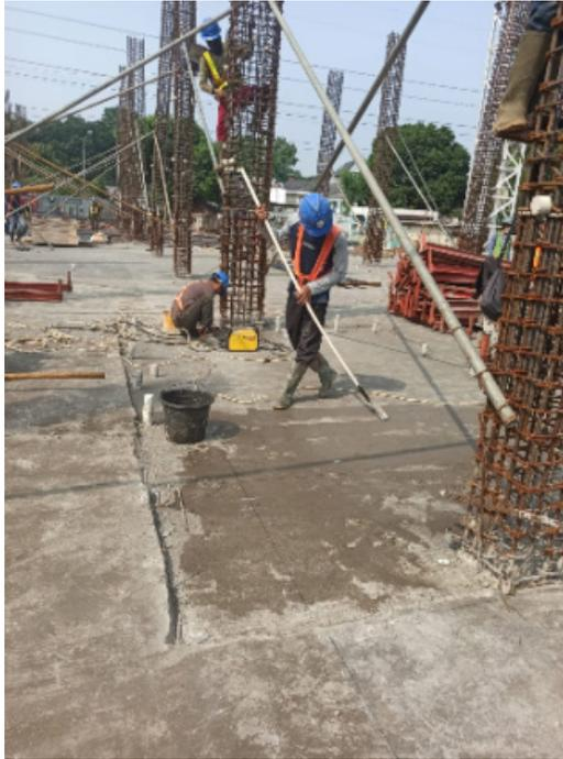
**Gambar 5.6** Pekerjaan Curing Balok
