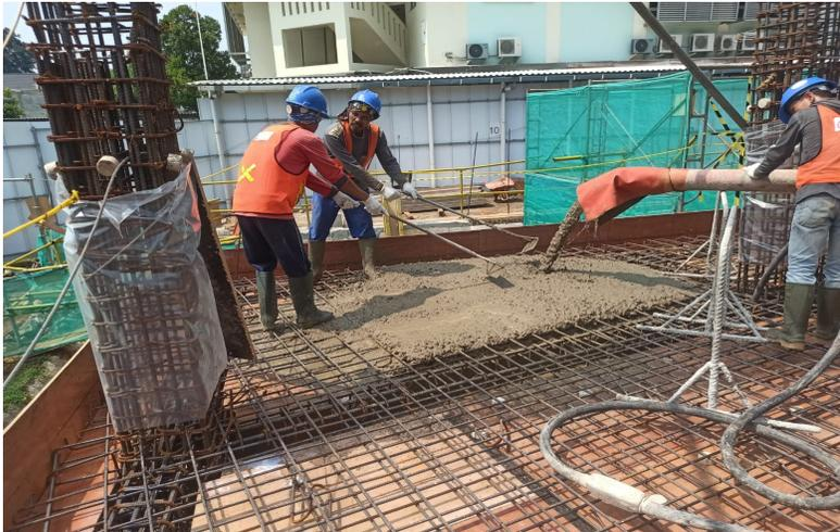
**Gambar 5.4 Pengecoran di Lapangan**
