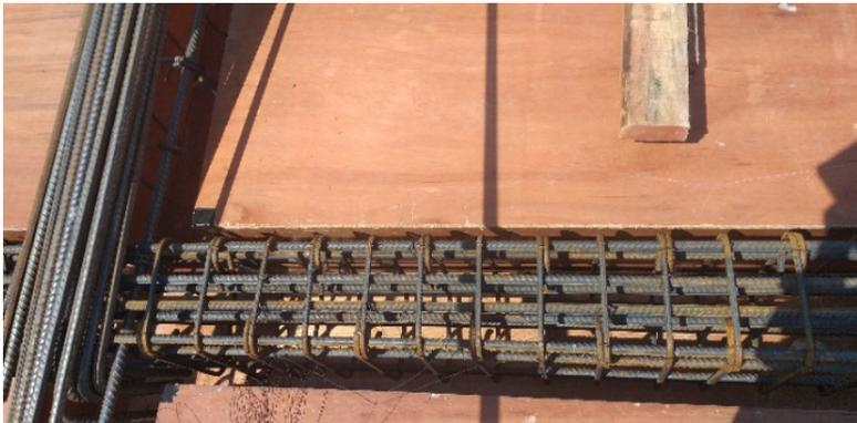
**Gambar 4.12** Pembesian Balok yang Telah Terpasang
