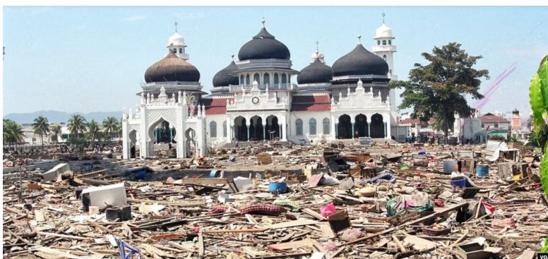
Gambar 15. Kerusakan akibat gempa dan tsunami di Aceh Tahun 2004 Sumber: https://www.voaindonesia.com/a/lima-belas-tahun-pasca-gempa-tsunami-aceh-sudahkah-warga-sadar-bencana-/5220570.html
