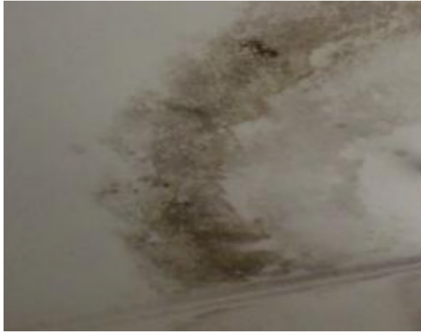
Gambar 3. Pelapukan Pada Plafon
