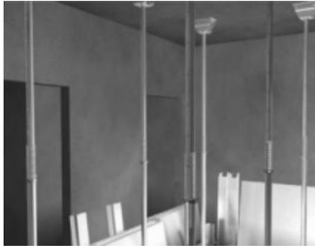
Gambar 1.30. Prop Head Saat Pembongkaran
