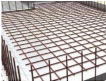
Gambar 1.28. Pembesian Secara Horizontal
