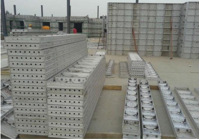
Gambar 4.1. Ketersediaan Komponen Bekisting Aluminium
