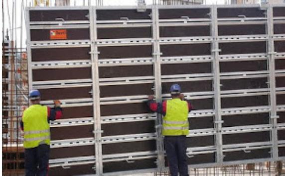
Gambar 3.8. Tenaga Kerja Ahli Bekisting Aluminium
