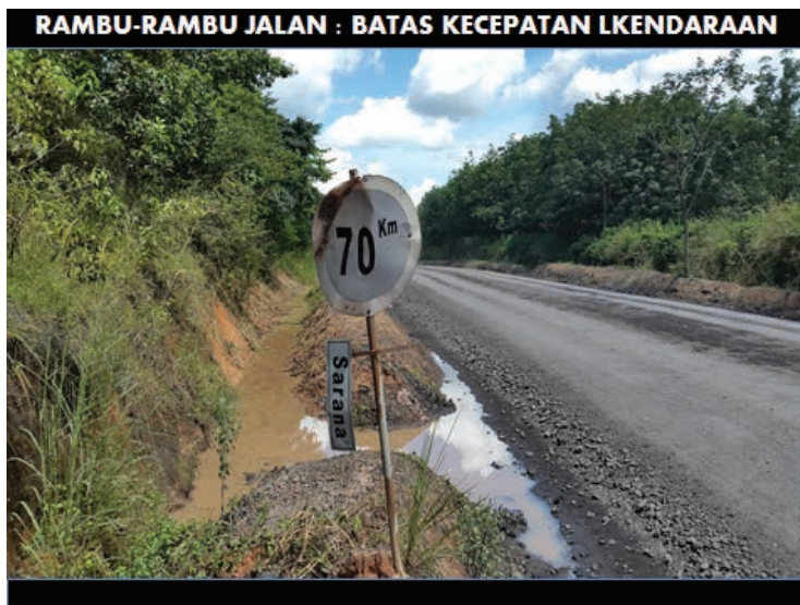
Gambar 6.4 Rambu batas kecepatan dump truck dan kendaraan staf
